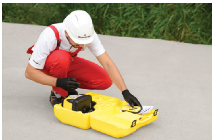
2 Se verifică planeitatea plăcii de beton cu ajutorul unei nivele laser.
