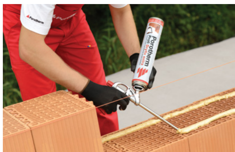
9 Se aplică două cordoane de spumă Porotherm Profi Dryfix extra pe o distanță de maxim 1 - 1,5 m.
