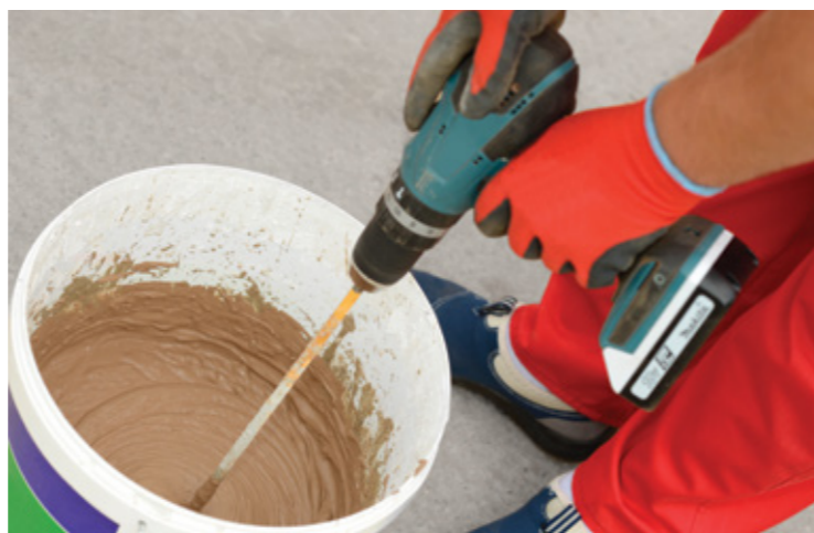
6 Se realizează amestecul de mortar Porotherm Profi în rost subțire cu apă, respectând indicațiile de pe ambalaj.
