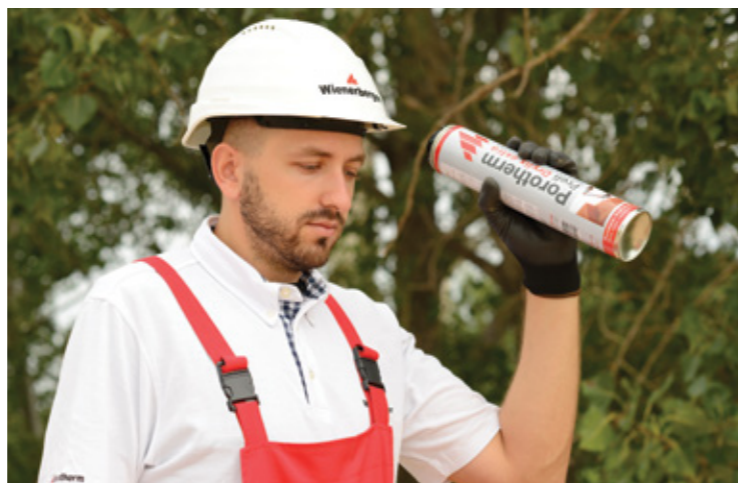
6 Se agită spuma Porotherm Profi Dryfix extra de 20 de ori.
