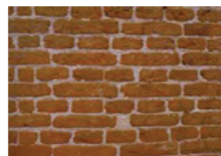
• Rost vertical și orizontal de mortar.
