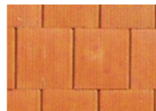
• Rost orizontal subțire de mortar. Blocuri ceramice cu îmbinare N+F.
