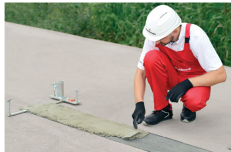
3 Se nivelează primul strat de mortar, preluând din denivelările plăcii.
