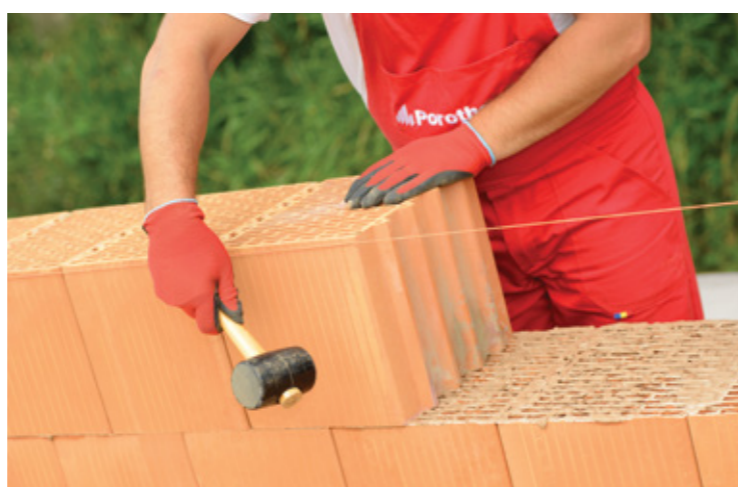
10 Se fixează următoarele blocuri ceramice cu ajutorul ciocanului de zidărie.
